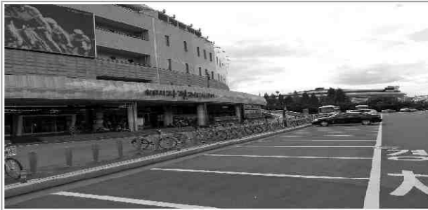
녹지공간 조성공사 전
